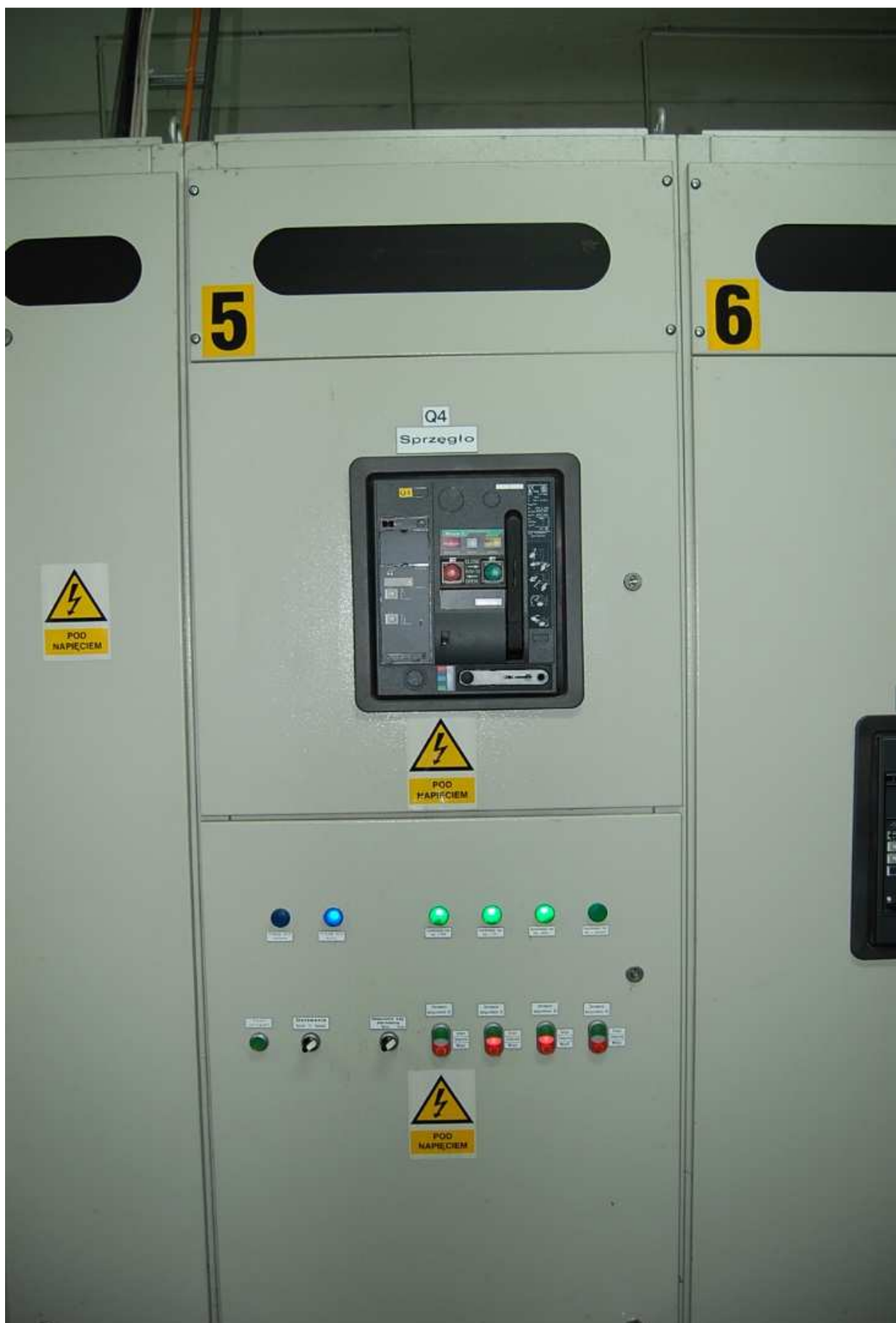
Pole SZR w rozdzielni RG1
