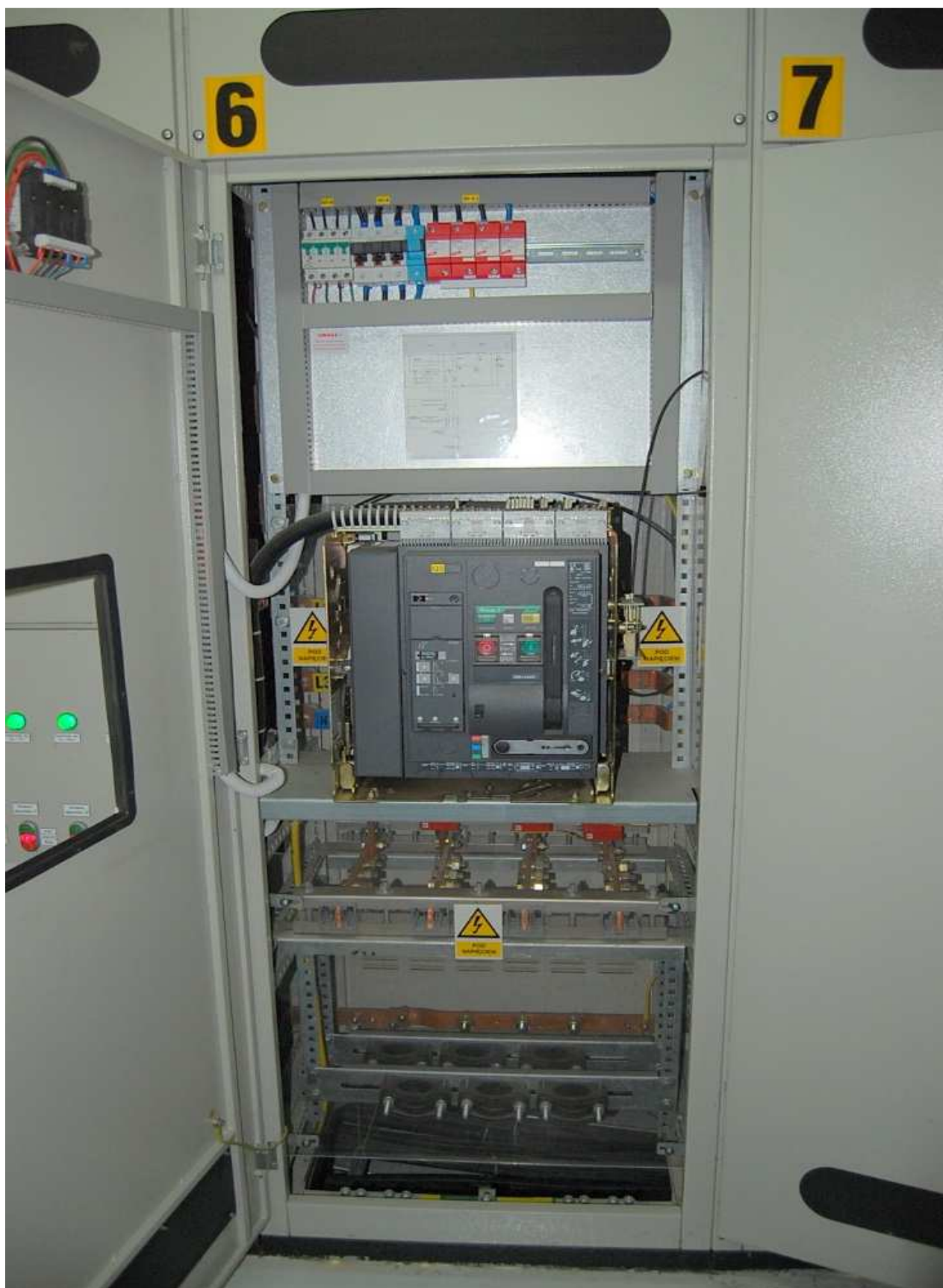
Pole zasilania z agregatu rozdzielni RG1 – widok ogólny
