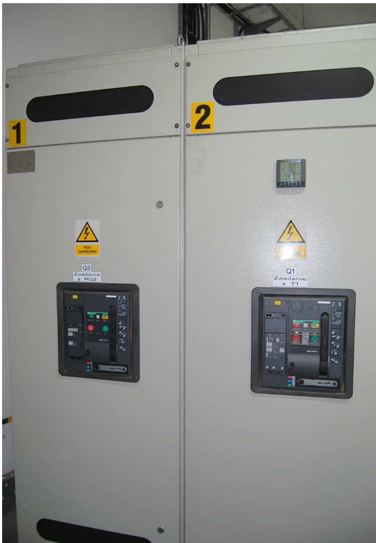
Pola zasilające rozdzielni RG1 z rozdzielni RG2 i transformatora T1
