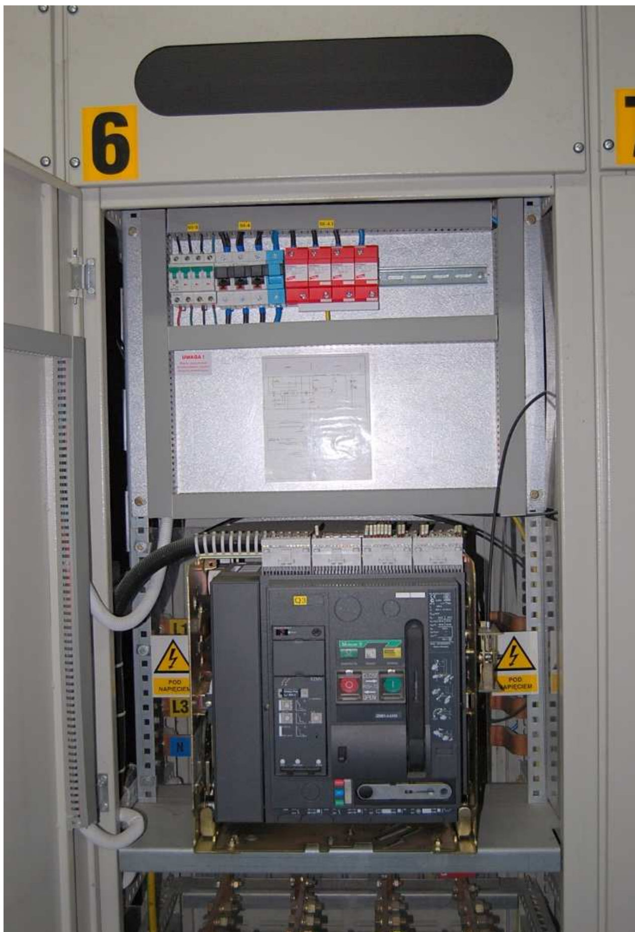
Pole zasilające z agregatu rozdzielni RG1 – widok wyłącznika
